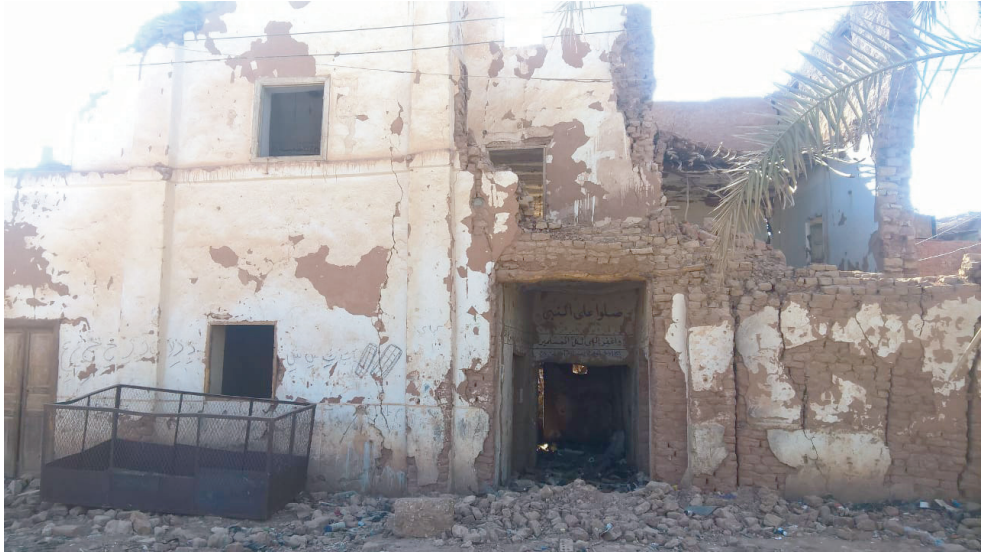
صورة (٦) يتضح أن الطوب اللبن هو المستخدم في عملية البناء
